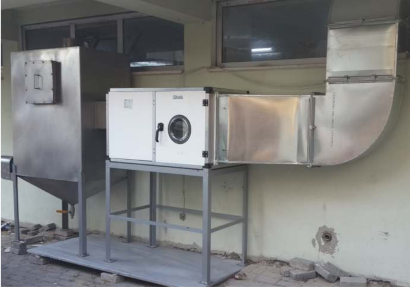
Pastane İin Karbon Filtre ve Islak Baca Filtre Uygulaması
