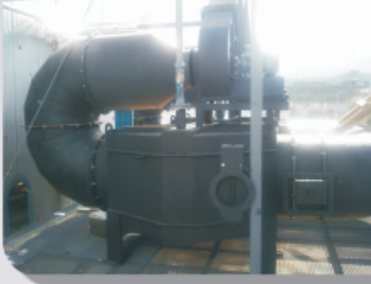
Otomatik Hava Damper Bağlantılı Hava-Su Ekonomizeri
