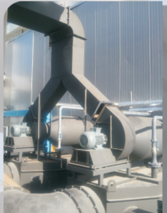
Ekonomizer - Fan - Baca Bağlantıları
