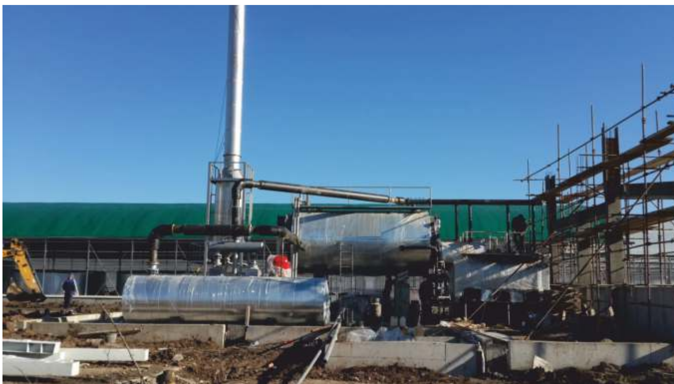
ZAGORA BIO EOOD STARA ZAGORA/BULGARİSTAN 24000 m 2 Sera için kömür yakıtlı sıcak su kazanı ve Ekonomizer destekli Isıtma sistemi devreye alınmıştır.
